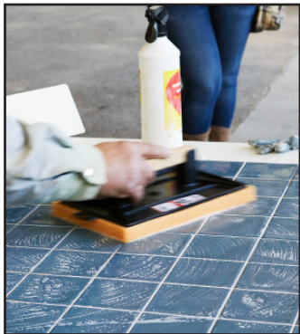
Fig.35/36/37 A argamassa deve ser aplicada com uma talocha de borracha, na diagonal relativamente à direção das juntas. Garanta a uniformidade da aplicação das argamassas nas juntas, de forma a aumentar a durabilidade das mesmas.
