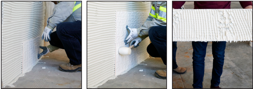
Fig.24 De seguida, aperte a peça contra o suporte de forma a esmagar os cordões de cimento cola, garantindo que a totalidade da área fica preenchida. Fig.25 Bata o material cerâmico com martelo de borracha branca, para garantir a aderência total do tardo da peça ao suporte. Fig.26 Ocasionalmente, levante a peça para verificar se a técnica de colagem e o tamanho da talocha foram adequados ao formato da mesma, e se a transferência da cola foi eficaz.
