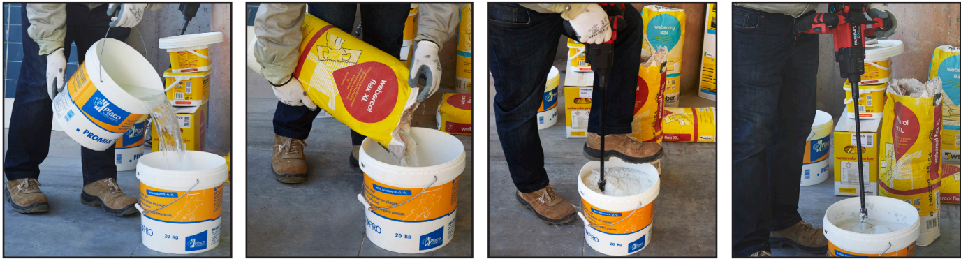
Fig. 17/18/19 Misture o conteúdo do saco de cimento cola com água limpa, utilizando um misturador elétrico de baixa rotação, até obter uma mistura homogênea e sem grumos. Deixe repousar dois minutos e misture novamente.
