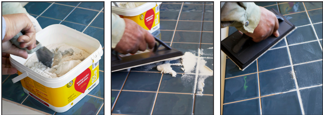
Fig.35/36/37 A argamassa deve ser aplicada com uma talocha de borracha, na diagonal relativamente à direção das juntas. Garanta a uniformidade da aplicação das argamassas nas juntas, de forma a aumentar a durabilidade das mesmas.
